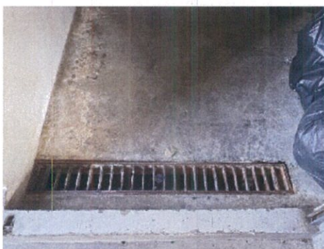
ภาพที่ 2-28 ท่อระบายน้ำในห้องพักมูลฝอย
